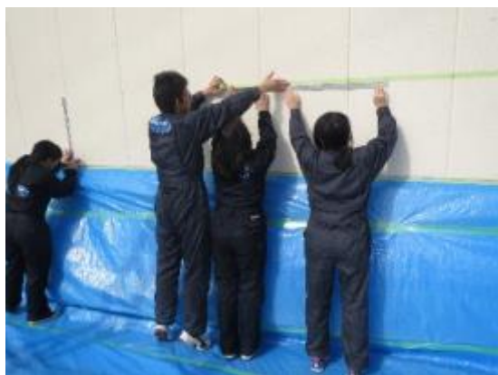
壁の養生と基準線の作成
